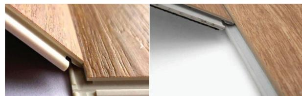
**! IMPORTANTE:** La superficie sobre la que se instalará el piso debe estar totalmente plana, sin ondulaciones para evitar roturas o quiebres del material.
